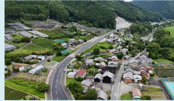
物資輸送の確保・孤立化対策 (緊急輸送道路の整備)
