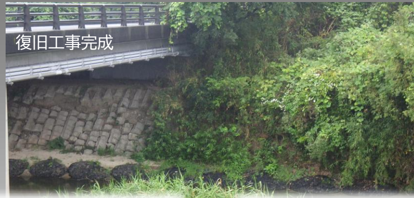
県単独費① 二級河川三滝川（左岸） （四日市市平尾町地内）
