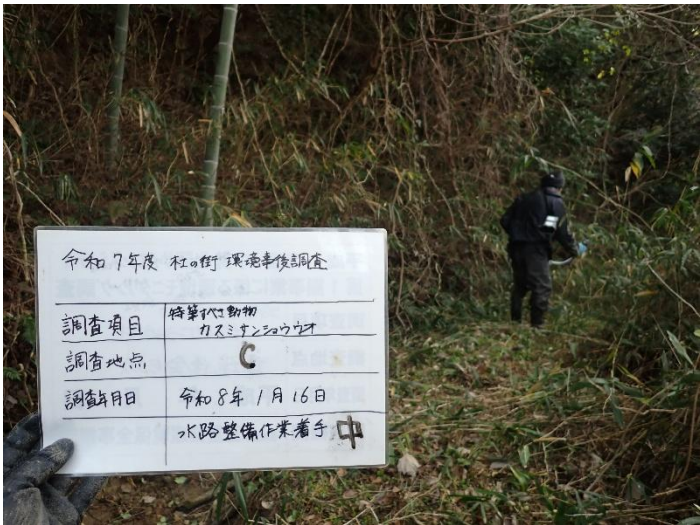
写真 2-4-3 移殖地整備状況（水路整備状況）移殖地No.C 令和8年1月16日
