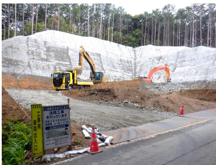
長谷調整池築造予定地の造成状況（多気町）
