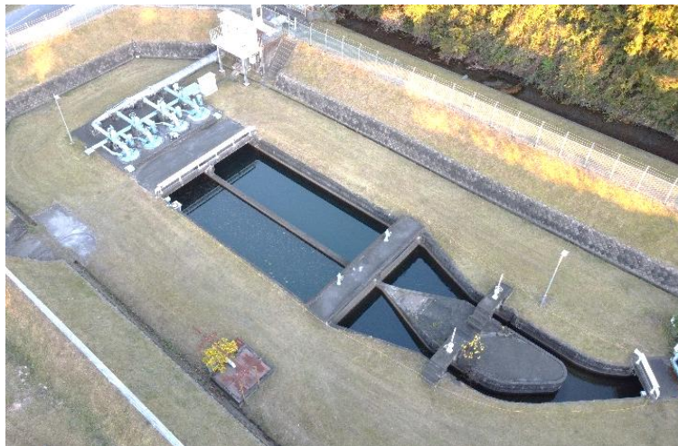
浸水対策が必要な高野浄水場取水施設 (津市)
