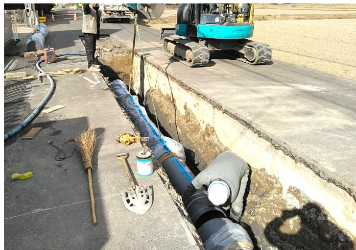
送水管布設替工事の施工状況（桑名市）
