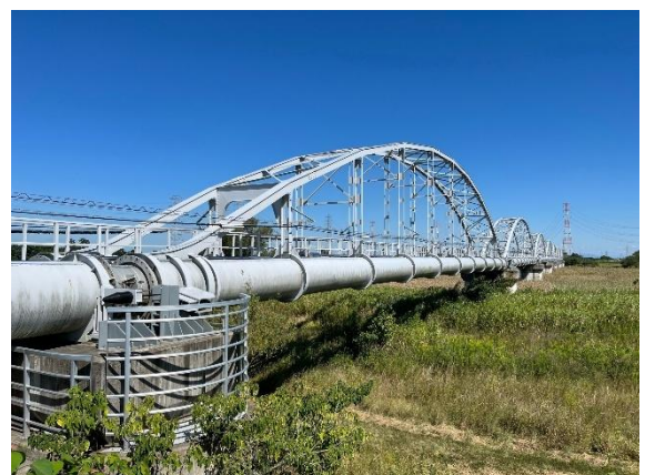
揖斐川水管橋(桑名市)
