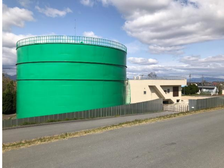
耐震化が必要な既設の 新屋敷取水所配水池（松阪市）
