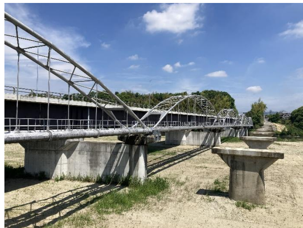
塗り替え予定の雲出川水管橋（津市）
