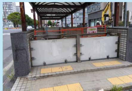
(地下出入口の止水板(手動)と出入口のかさ上げ)
