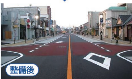
(主)上野大山田線 伊賀市・市街地等の緊急輸送道路
