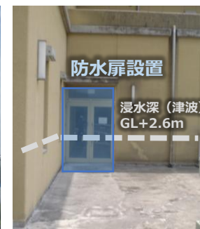
宮川浄化センター(スクリーンポンプ棟の耐水化)
