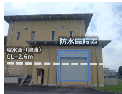
宮川浄化センター(スクリーンポンプ棟の耐水化)
