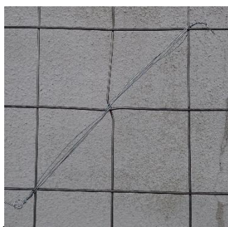
溶接部が損傷したら、針金でタスキ掛け補修
