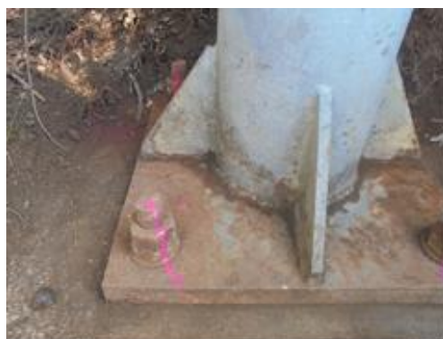
ベースプレートの腐食
