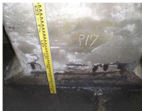
柱の鉄筋露出
