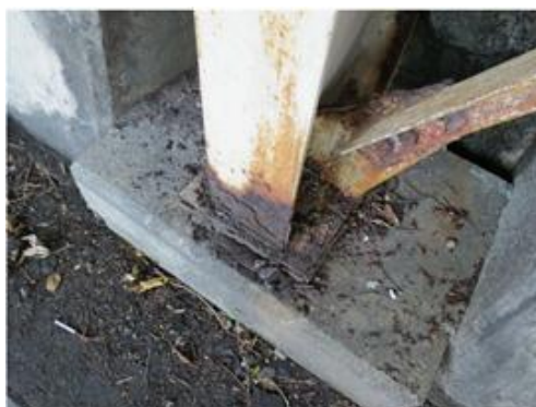
柱の腐食
