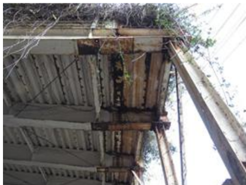
主梁・横梁・頂版の腐食
