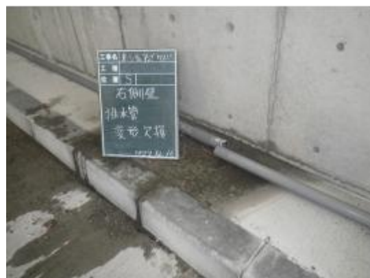
排水管の変形・欠損
