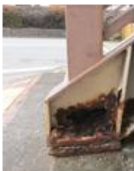
主桁階段部の腐食
