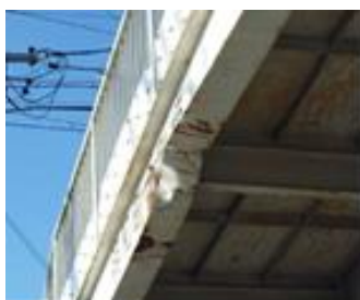
主桁階段部の腐食
