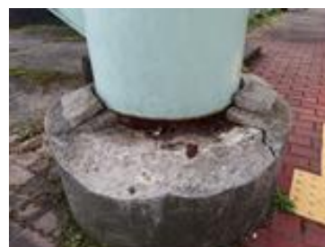
下部構造の腐食
