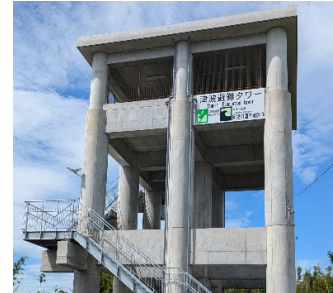
志摩市国府地区③津波避難タワー
