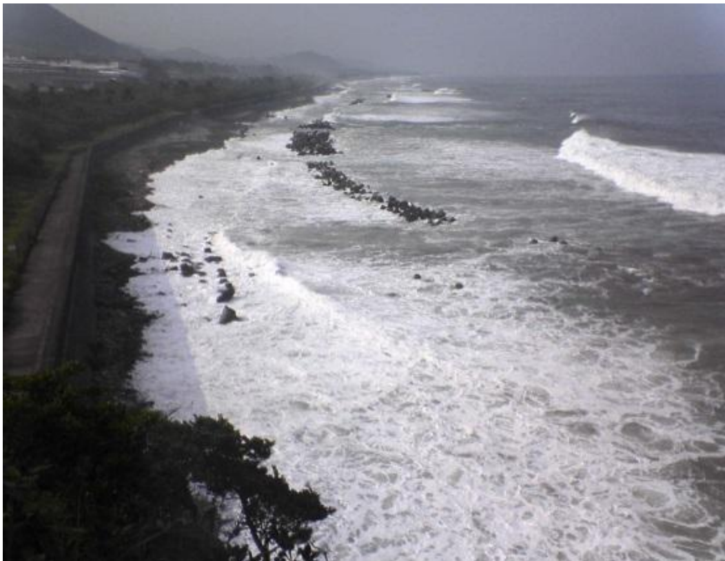
侵食後（平成 27 年 9 月撮影）
