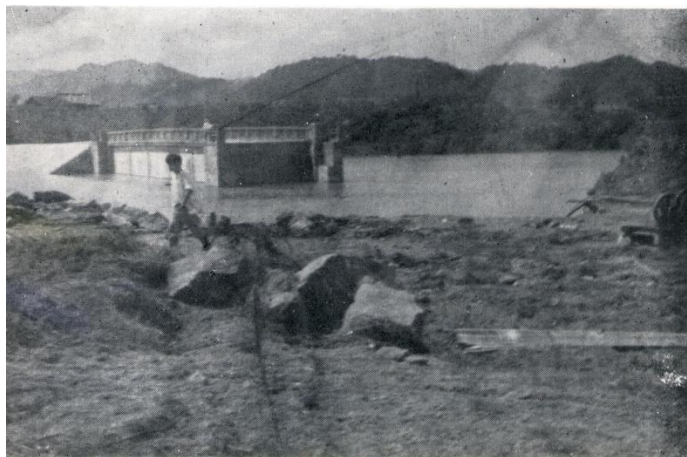
一般国道の流失（熊野市志原地内）
