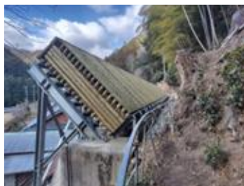
本体工（落石防護壁の構造部材）
