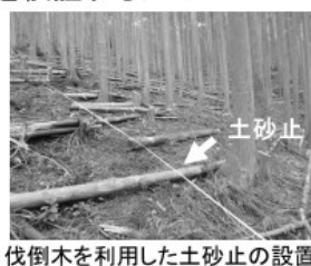
伐倒木を利用した土砂止の設置
