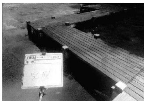
＜絆の森整備事業＞ ウッドデッキのリニューアル
