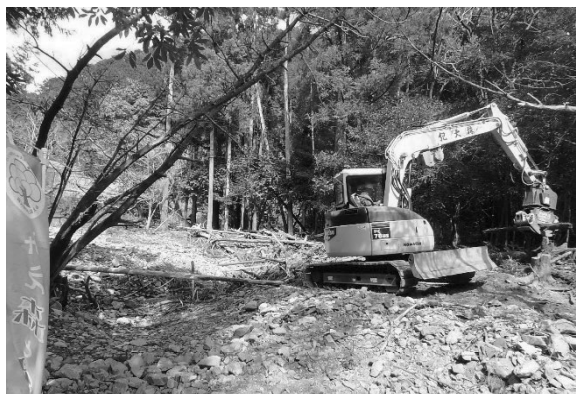
＜溪流倒木等処理事業＞ 溪流内流木の除去
