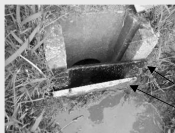
【上】門型堰板 【下】通常使用する堰板
