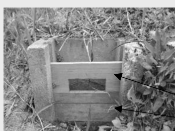
【上】門型堰板 【下】通常使用する堰板
