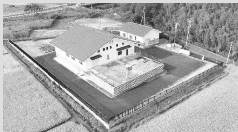
(農業集落排水施設)
