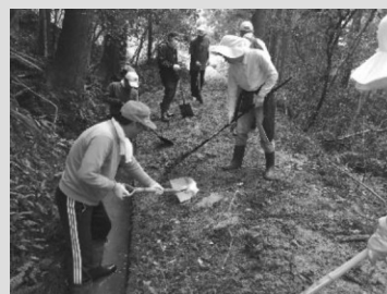
(水路の泥上げ)
