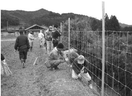
侵入防止柵の設置
