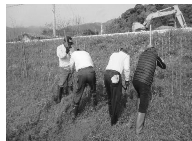
侵入防止柵設置の様子
