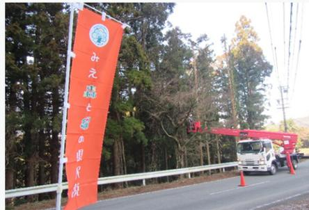
台風などの倒木被害によりライフラインを寸断する恐れのある電線沿いの危険木を、事前に伐採します。
