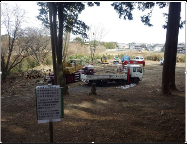
写真1 樹木の伐採作業
