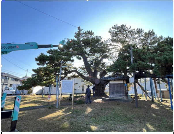
写真2 樹木の伐採作業
