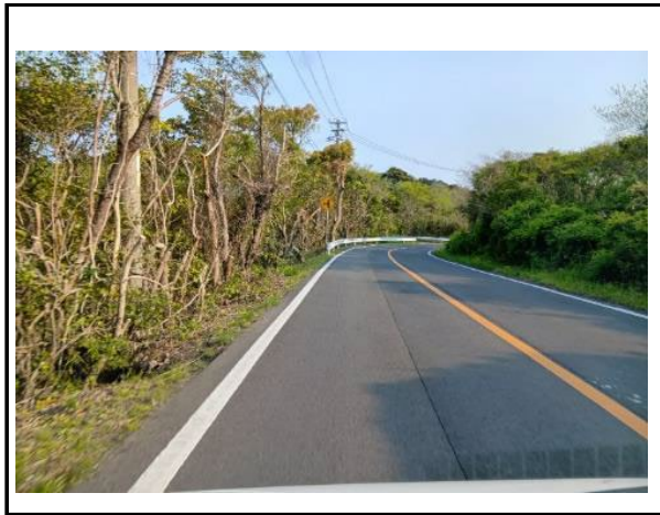
写真6 伐採箇所終点付近（作業後）
