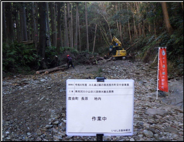
写真1 撤去作業中①
