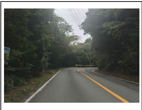
写真3 伐採箇所中間付近（作業前）
