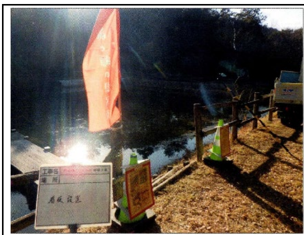
写真5 PR看板設置
