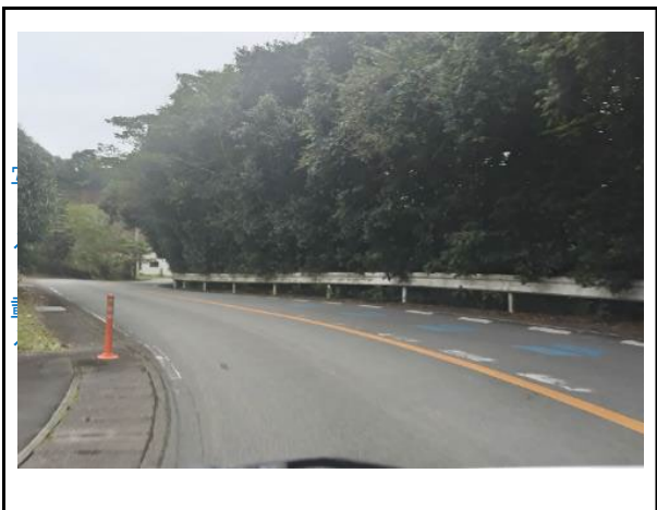
写真1 伐採箇所始点付近（作業前）
