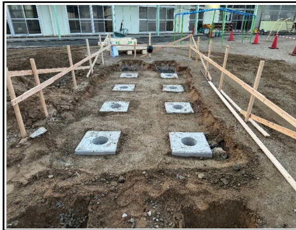
写真2 木製遊具工事中 基礎工
