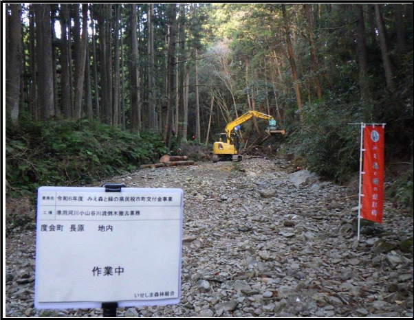
写真2 撤去作業中②
