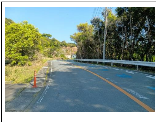
写真2 伐採箇所始点付近（作業後）
