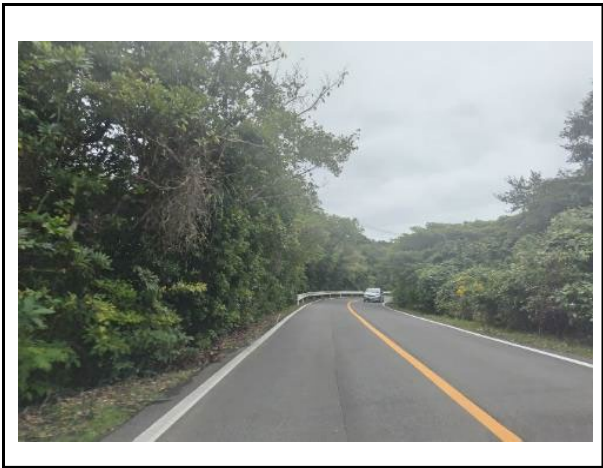
写真5 伐採箇所終点付近（作業前）
