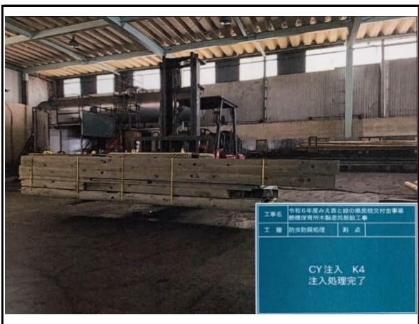
写真3 木製遊具 防虫防腐処理
