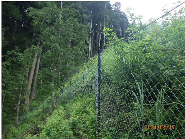
防護柵整備後の点検時の写真（津市）
