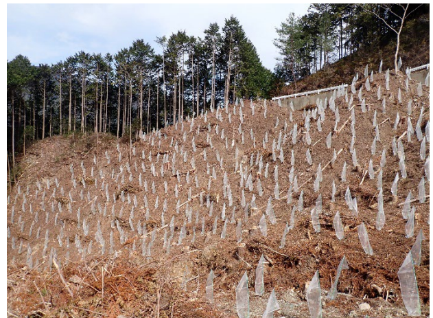
防護チューブ設置の様子（松阪市）
