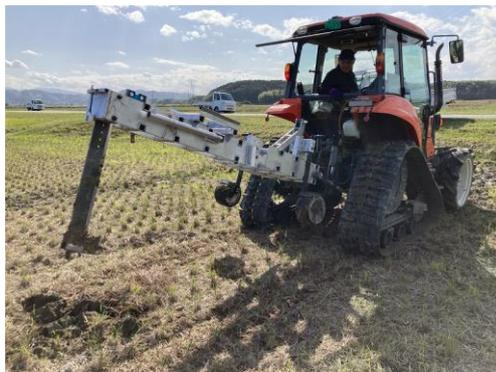
図2 排水管の埋設方法（本暗渠施工時）
