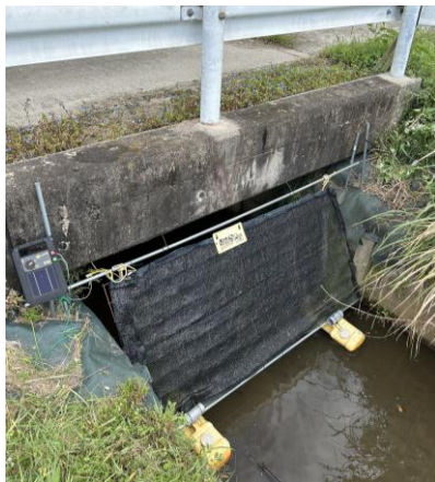
図2 現地の設置状況
