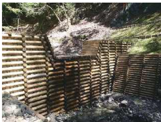
公共土木工事での木材利用
