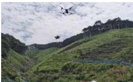
ドローンを用いた資材運搬
