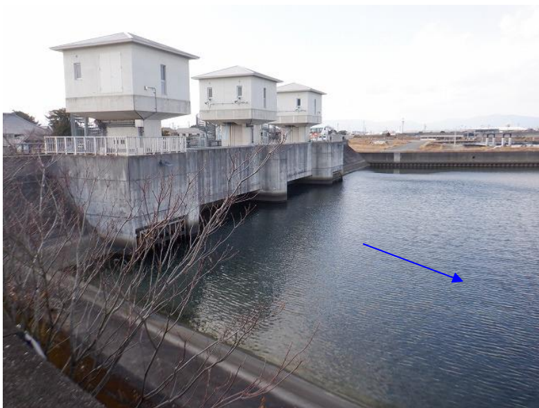
百々川 防潮水門
