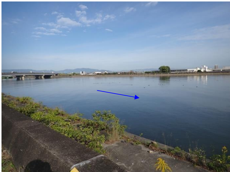
三渡大橋下流から上流方向
