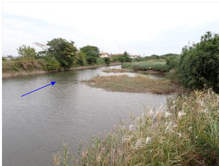
岩内川合流点から下流方向
