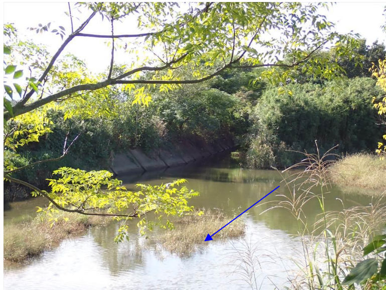
下流端から上流方向
