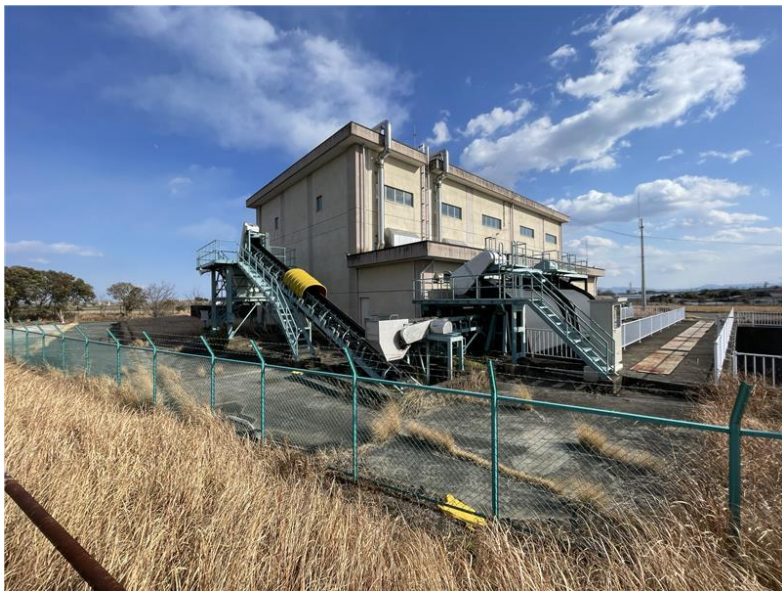
百々川 排水機場
