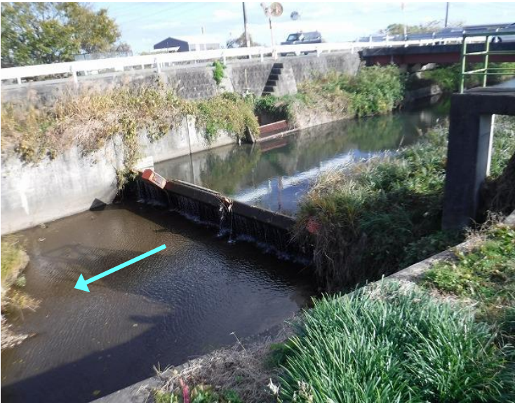
此亦(しまた)統合堰(堀坂川2.3k付近)
