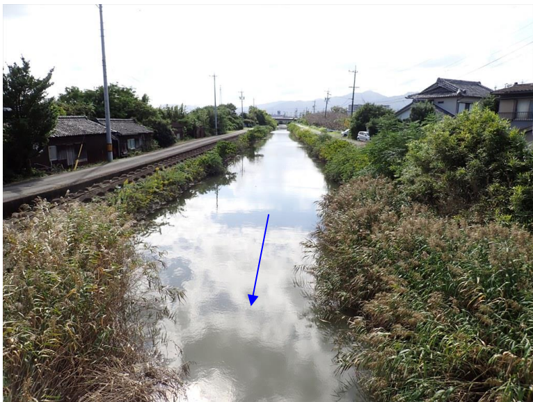
下流端から上流方向
