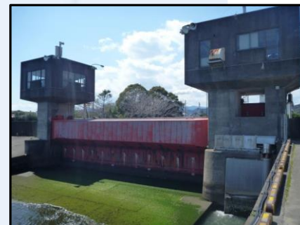
神内川防潮水門
