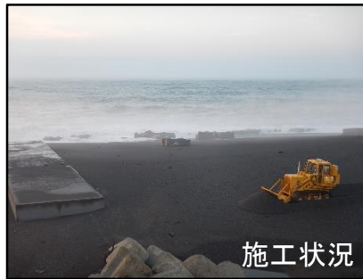
河口開削（志原川） 【御浜町】
