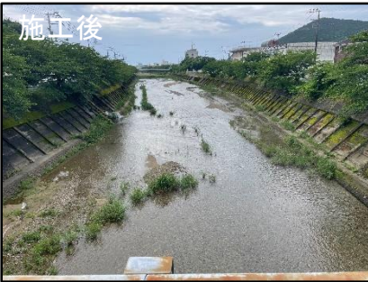
河道掘削（堆積土砂撤去）（井戸川） 【三重県】
