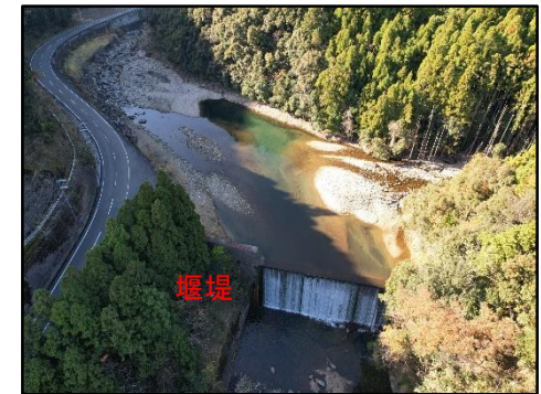
砂防堰堤堆積土砂撤去
