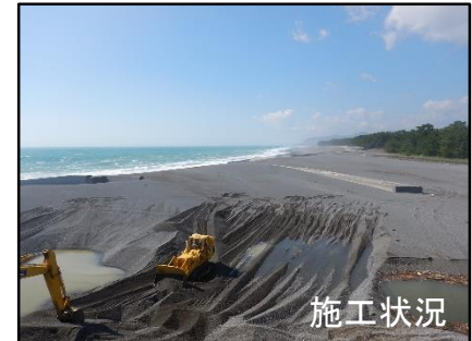
河口開削（志原川） 【御浜町】
