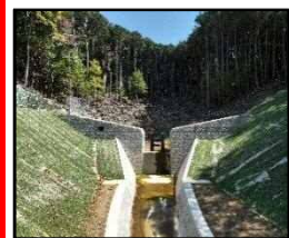
砂防堰堤の整備(名柄川支川1) 【三重県】
