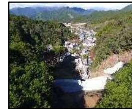
砂防堰堤の整備(猿谷) 【三重県】
