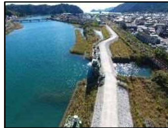
堤防強化事業(船津川) 【三重県】
