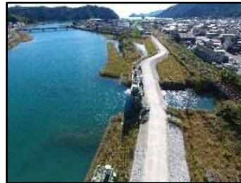
堤防強化事業(船津川) 【三重県】
