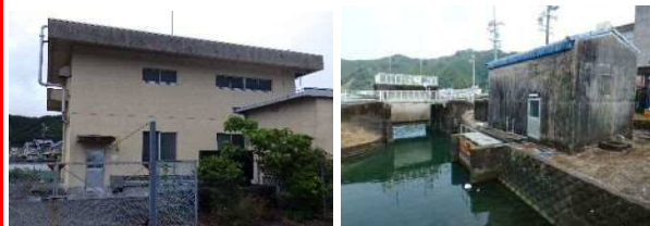
山本地区排水機場 (排水機場整備)【三重県】
