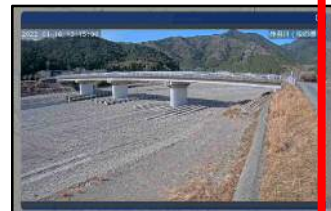
簡易型河川監視カメラ
