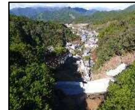
砂防堰堤の整備(猿谷) 【三重県】
