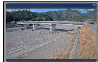
簡易型河川監視カメラ
