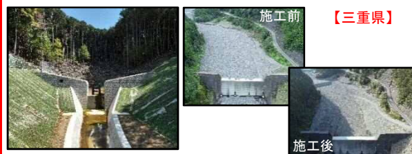
砂防堰堤の整備(名柄川支川1) 【三重県】
