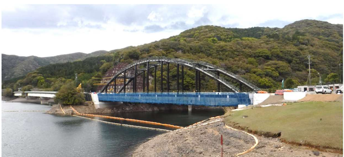
橋を建設しています
