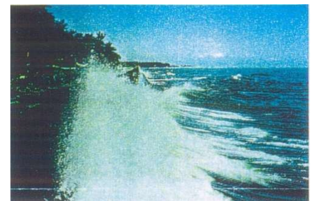
越波状況 (三重県伊勢市)
