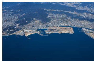
覆砂箇所（三河港：愛知県蒲郡市）
