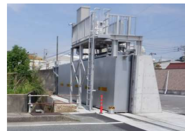
陸閘の改築 (衣浦港海岸：愛知県高浜市)
