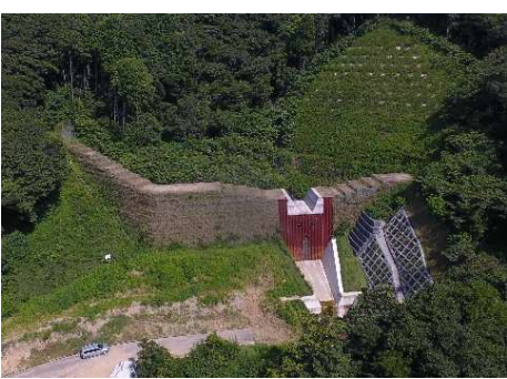
長平谷の砂防ダム（令和3年度完成）
