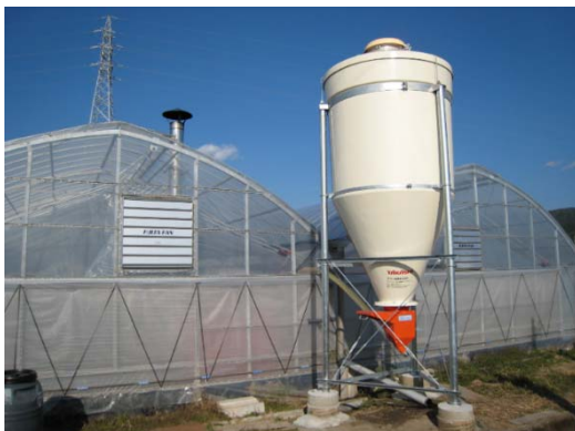
貯蔵タンクの設置スペース
