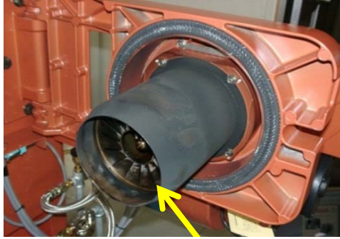
清掃前、ススで真っ黒のエアコーン、ディフューザーの状態
