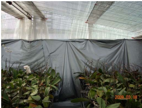
温室北面へ断熱資材を固定張り
