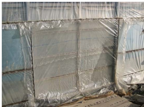
使用しない出入口を目張り
