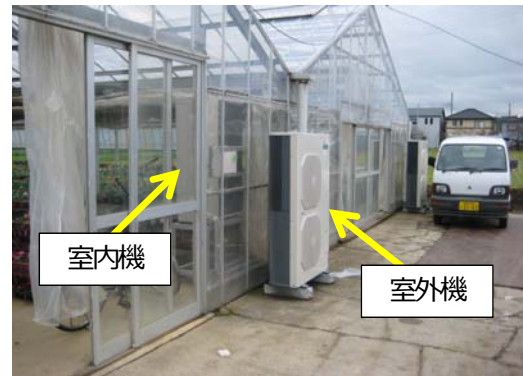
室内機と室外機の適切な設置例
