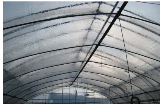
散水管より地下水を散水している様子
