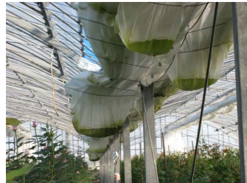
金魚鉢状に膨らんだ内張カーテン
