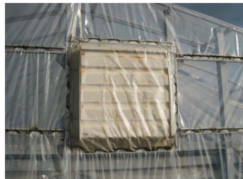
換気扇のシャッターを目張り
