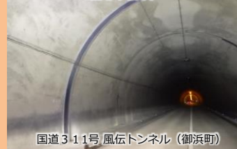
国道311号 風伝トンネル (御浜町)
