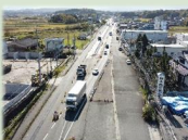
一般国道368号（伊賀市張拉幅1工区）
