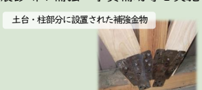
土台・柱部分に設置された補強金物
