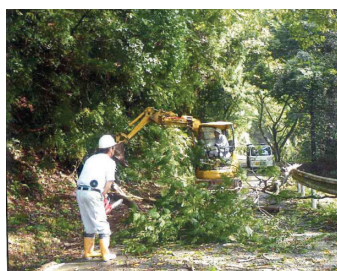
大雨による土砂崩落・倒木発生時の撤去作業
