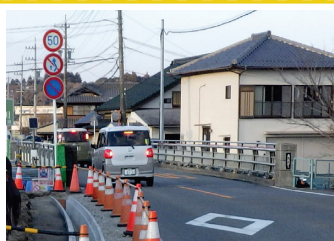
⑮国道 306 号(四日市市)
