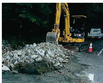
大雨による土砂崩落・倒木発生時の撤去作業
