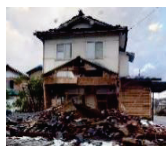
能登半島地震における住宅倒壊
