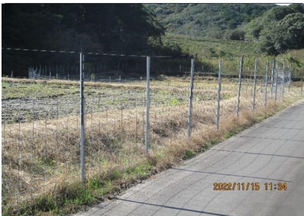
シカ対策としてイノシシ柵上段に 架線設置(R4.11)
