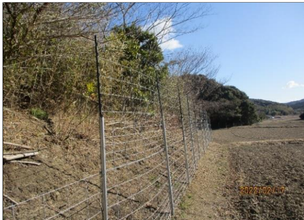
完成(R4.2)高低差箇所は嵩上げ
