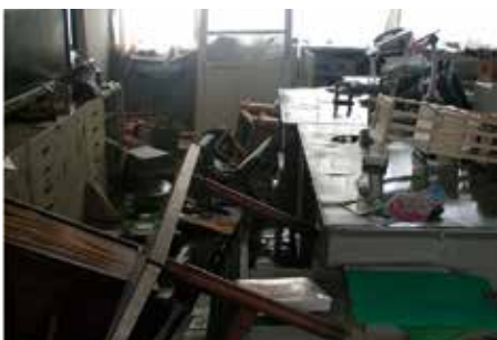
玻璃破碎的员工办公室
