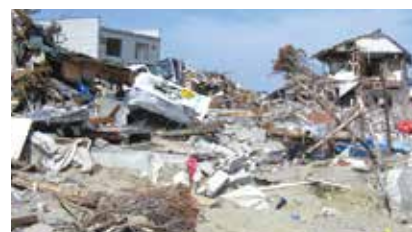
Zona de viviendas destruidas
