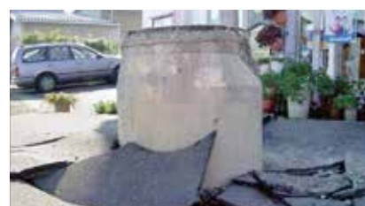
Pozo de registro que sobresale de la superficie
