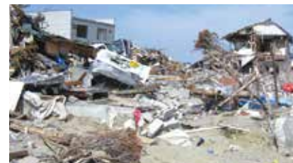
Conjunto residencial destruído
