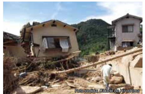
Deslizamento de terra
