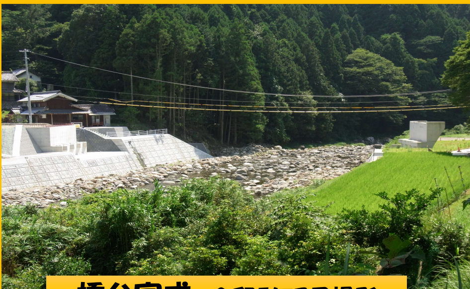
橋台完成 令和5年7月撮影
