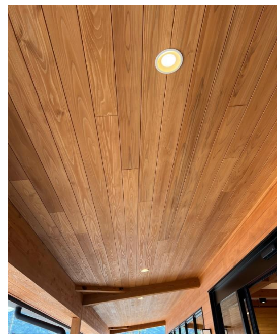
軒天（県産スギ板張り）
