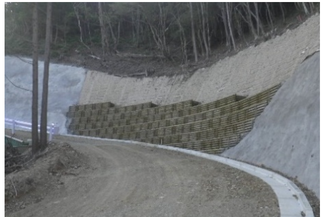
高耐久性木製枠工
