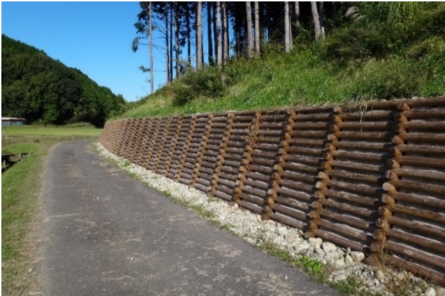
木製校倉式土留工
