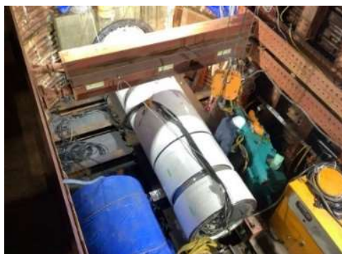
内宮幹線管渠延伸工事
