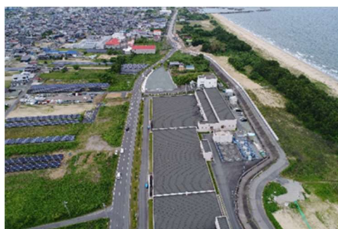
志登茂川浄化センター
