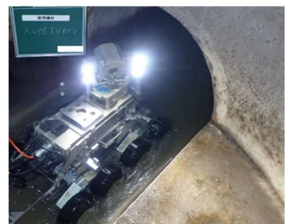
下水道管路の調査状況
