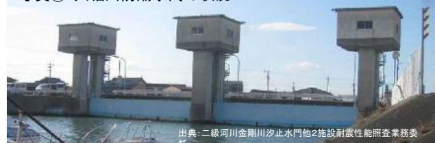
写真②：大堀川防潮水門の状況
