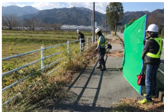
道路の除草作業 (松阪市)
