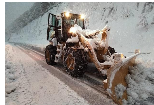
道路の除雪作業 (いなべ市)
