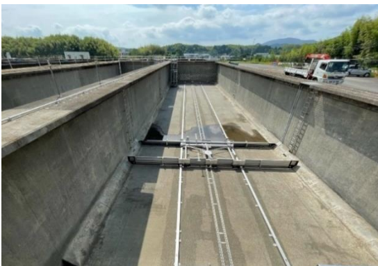
更新中の多気浄水場沈澱池汚泥掻寄機 (多気町)
