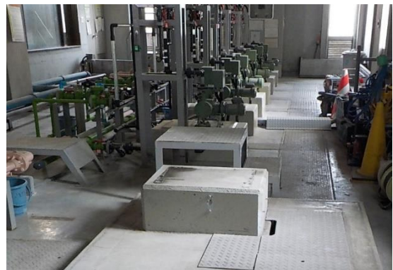
更新中の播磨浄水場苛性ソーダ注入設備* (桑名市)
