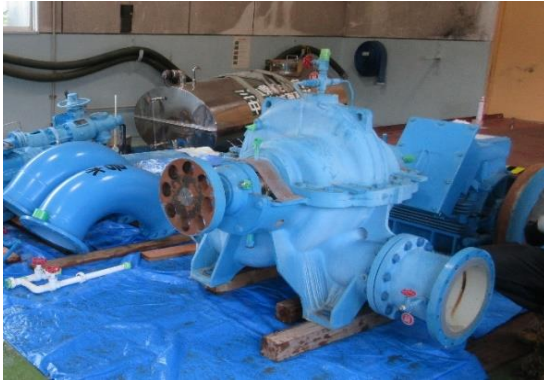
分解点検中の高野浄水場送水ポンプ設備 (津市)
