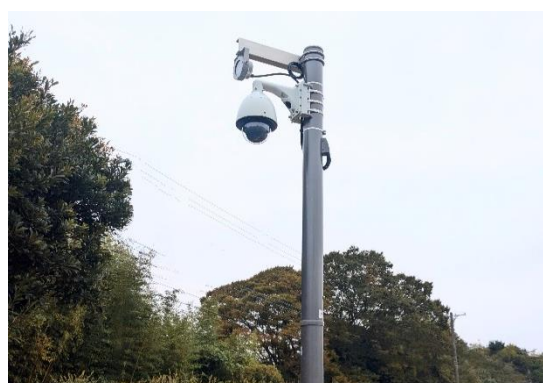
更新中の北勢水道事務所管内 ITV 設備※ (四日市市)
