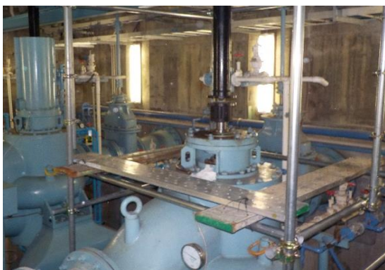
分解点検中の千本松原取水所 ポンプ設備（桑名市）
