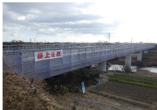
塗装塗り替え中の朝明川水管橋 （四日市市）
