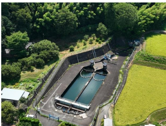
浸水・土砂対策工事を実施する沈砂池（多気町）
