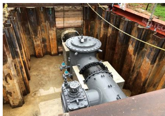
不断水工法※による制水弁設置状況 (四日市市)
