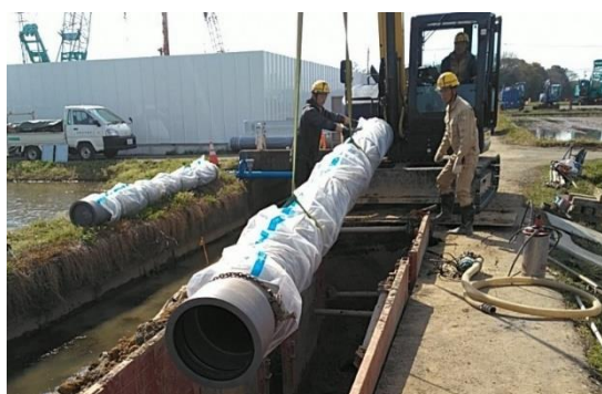
送水管布設替工事の施工状況 (桑名市)
