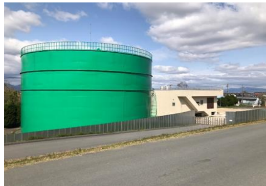
配水池築造工事を実施する 新屋敷取水所配水池（松阪市）
