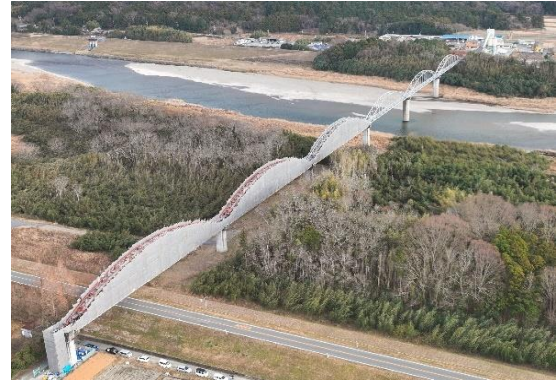
塗装塗り替え中の宮川水管橋 (玉城町)
