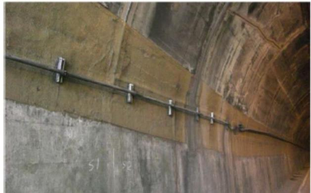
付写真-2.4.6 鋼板接着（左）・繊維シート接着（右）例
