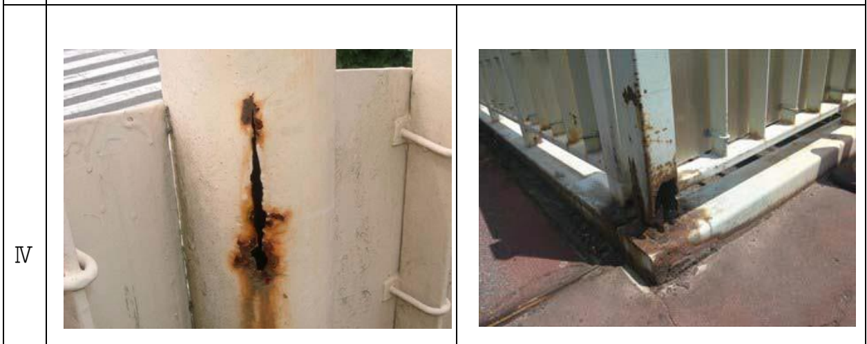
例：明らかな断面欠損、貫通や著しい板厚減少がある場合
